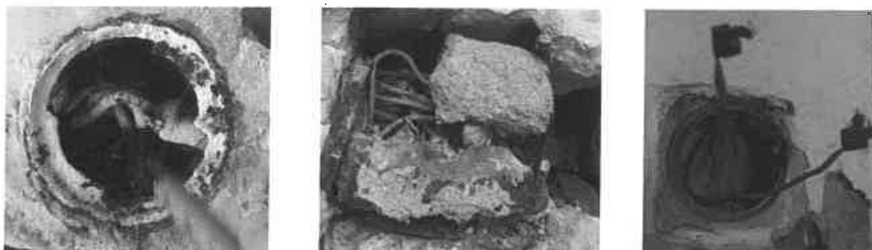
Foto 15. Aparataje din diferite etape, majoritatea nefuncționale, respectiv doze de aparat cu conductoare neizolate
