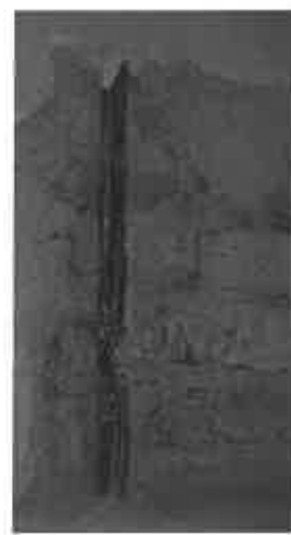
Foto 20. Conductor cu izolație textilă montat direct sub tencuială
