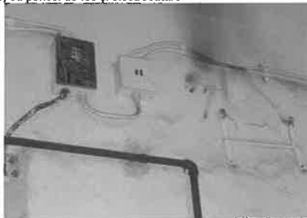
Foto 18. Trasee aparente și cutii de distribuție aparente, montate la înălțime, inaccesibile pentru intervenție
