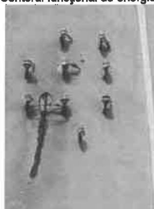
Foto 4. Console ale instalației electrice aeriene de pe fațada principală
