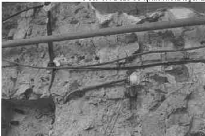
Foto 17. Trasee îngropate anterior, dar actualmente aparente cu pericol de electrocutare, într-o avansată stare de degradare
