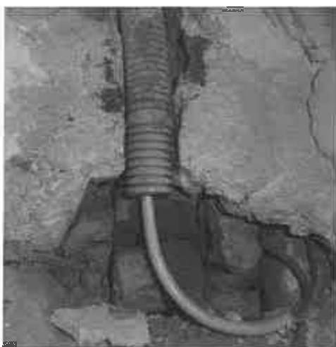
Foto 19. Instalație electrică îngropată executată în tub de protecție de plastic, respectiv metalic
